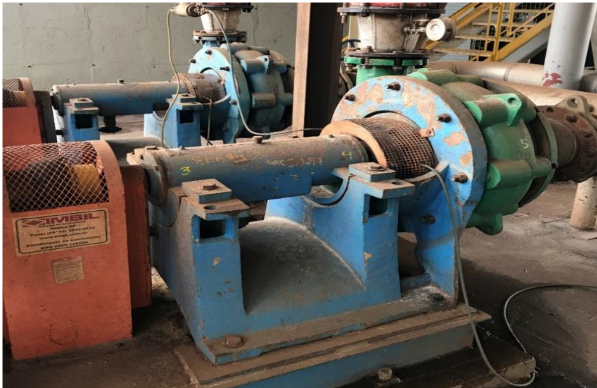
Figura 14 - Bomba Centrífuga Modelo ITAP
