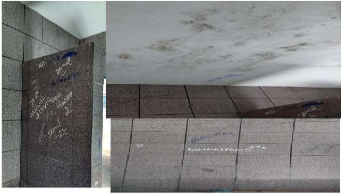
Figura 18 Banheiro masculino paredes e teto da Unidade B. Fonte (da autora )
