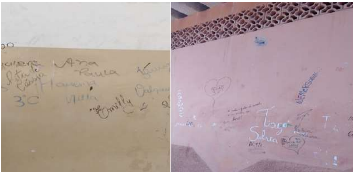
Figura 16 Parede externa, parte detrás do pavilhão da Unidade B. Fonte ( da autora )
