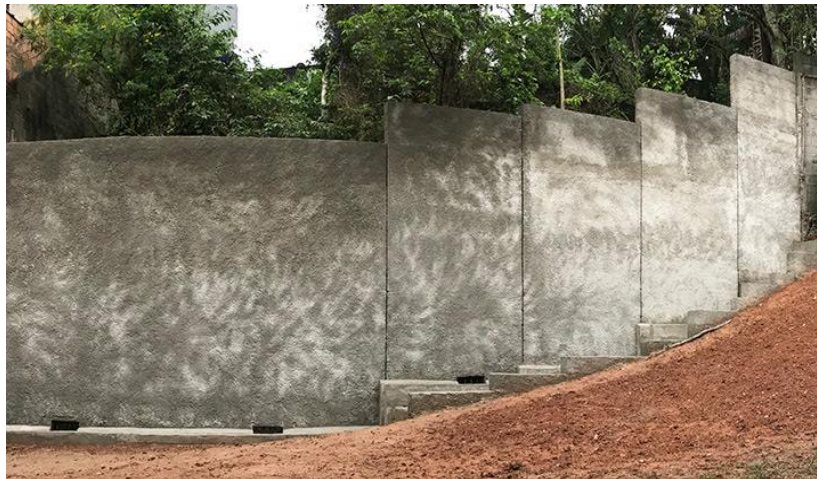
Figura 11 - Muro de concreto armado.
