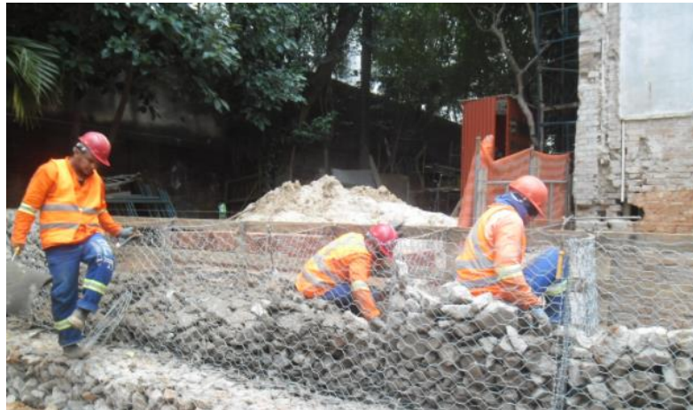
Figura 20 - Enchimento do elemento.
