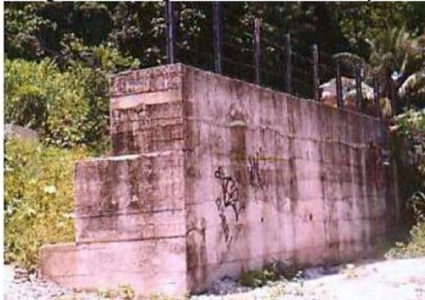
Figura 6 - Muro de peso.
