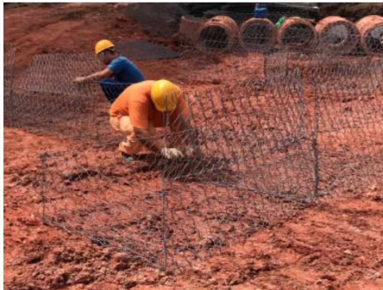
Figura 18 - Montagem das caixas.
