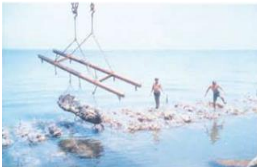
Figura 24 - Instalação do gabião tipo saco.
