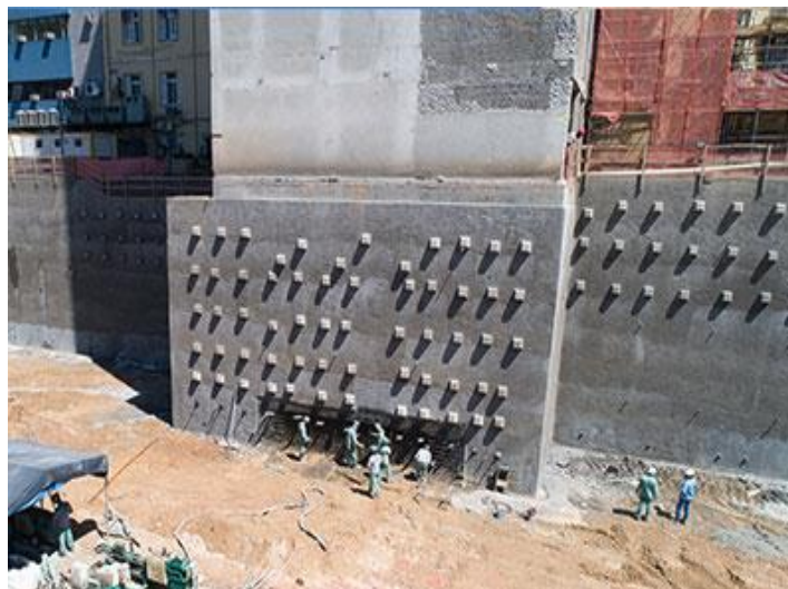
Figura 9 - Cortinas atirantadas.
