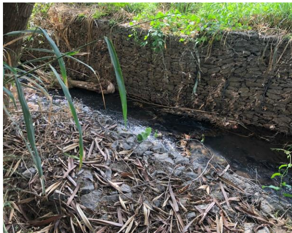
Figura 39 - Uso do gabião no bairro vila Santa Maria de Nazareth
