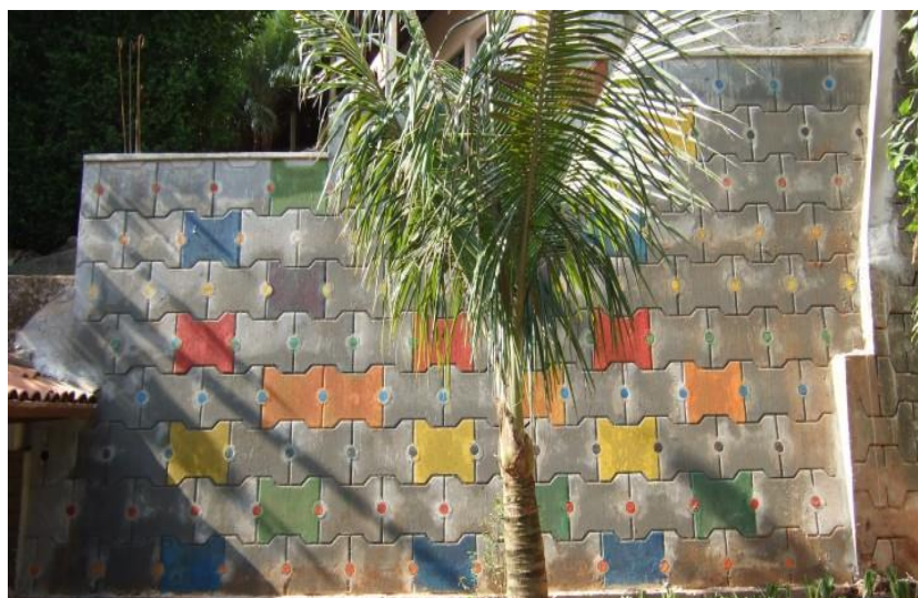
Figura 12 - Aplicação de rimobloco.
