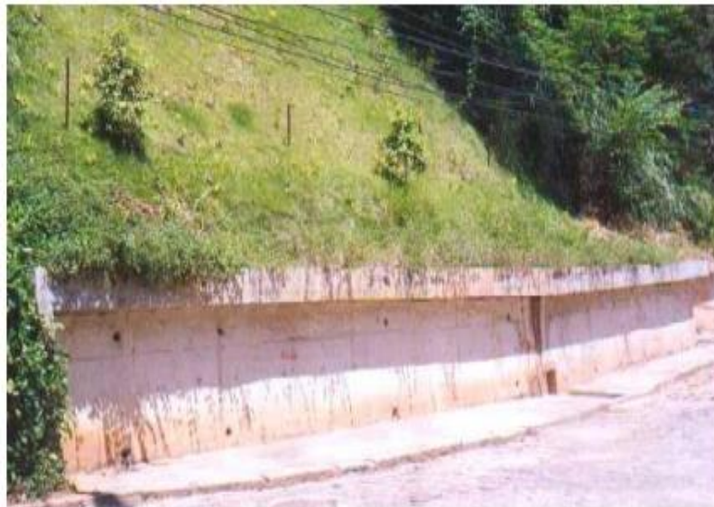
Figura 13 - Muro de flexão.
