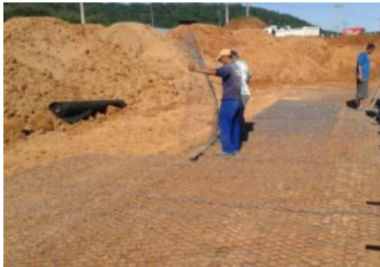
Figura 17 - Abertura da malha.
