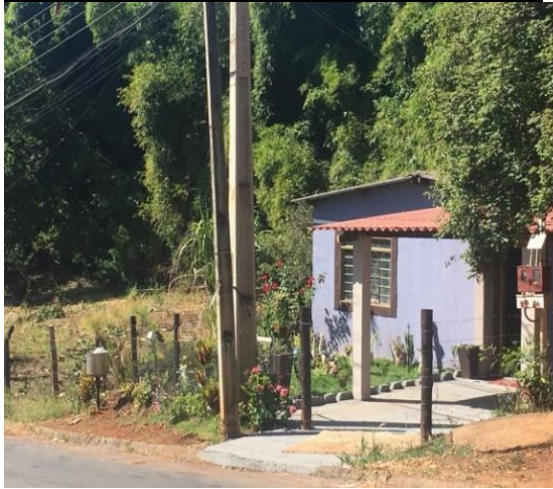
Figura 33 – Moradia próxima ao córrego Água Fria no bairro JK.
