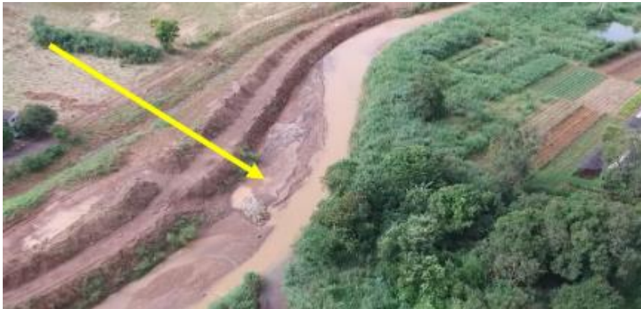
Figura 32 - Assoreamento Água Fria.
