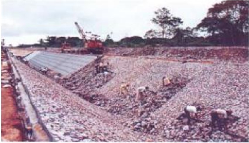
Figura 26 - Enchimento do gabião colchão reno.
