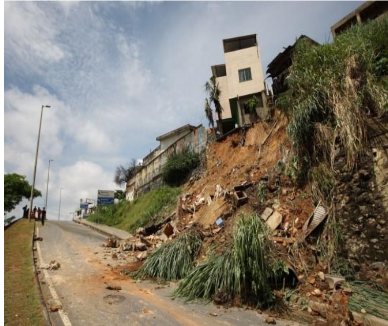
Figura 3 - Deslizamento de terra em Belo Horizonte-MG.
