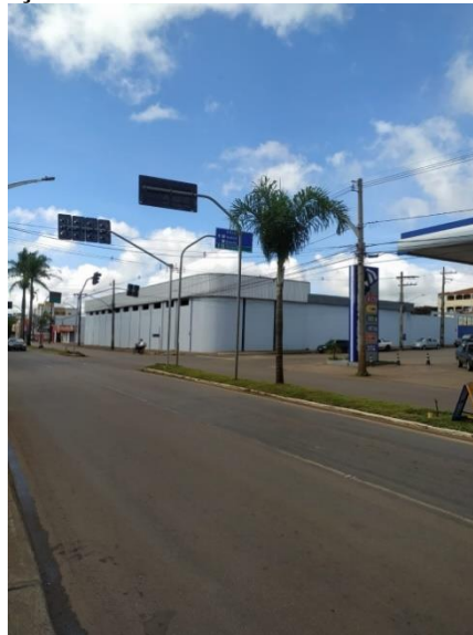
Figura 28 – Sinalização horizontal e vertical Avenida Juscelino Kubitscheck
