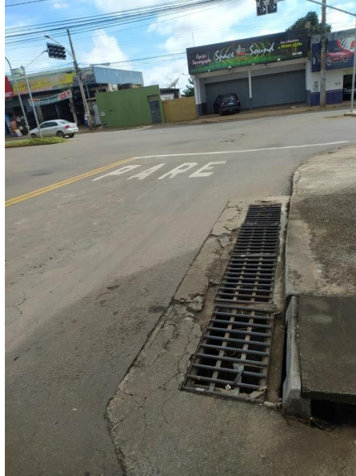
Figura 29 – Sinalização horizontal da Avenida F
