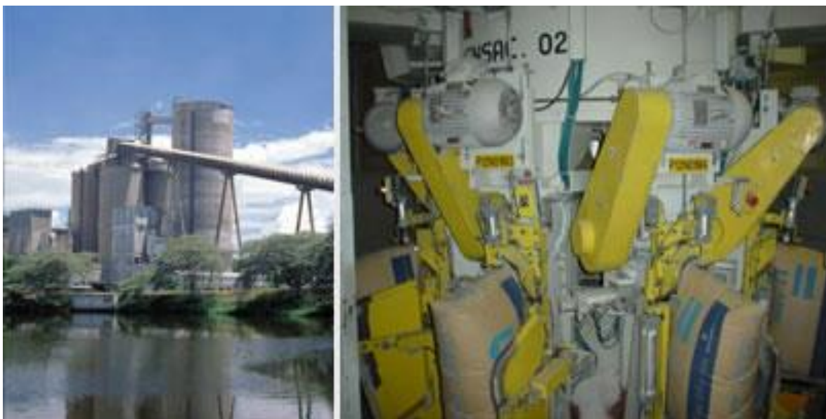
Figura 7 – Silo e Estocagem do Cimento
