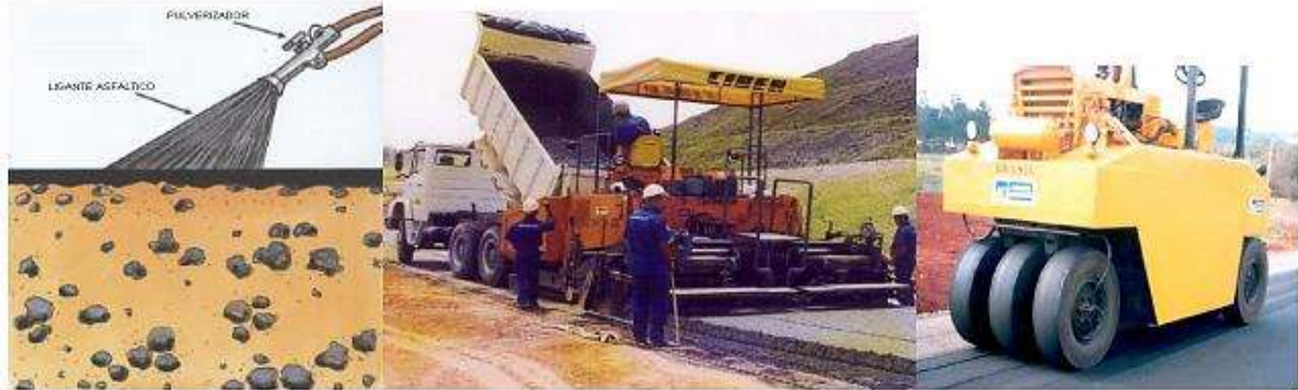
Figura 04 - Processo produtivo dos pavimentos flexíveis.
