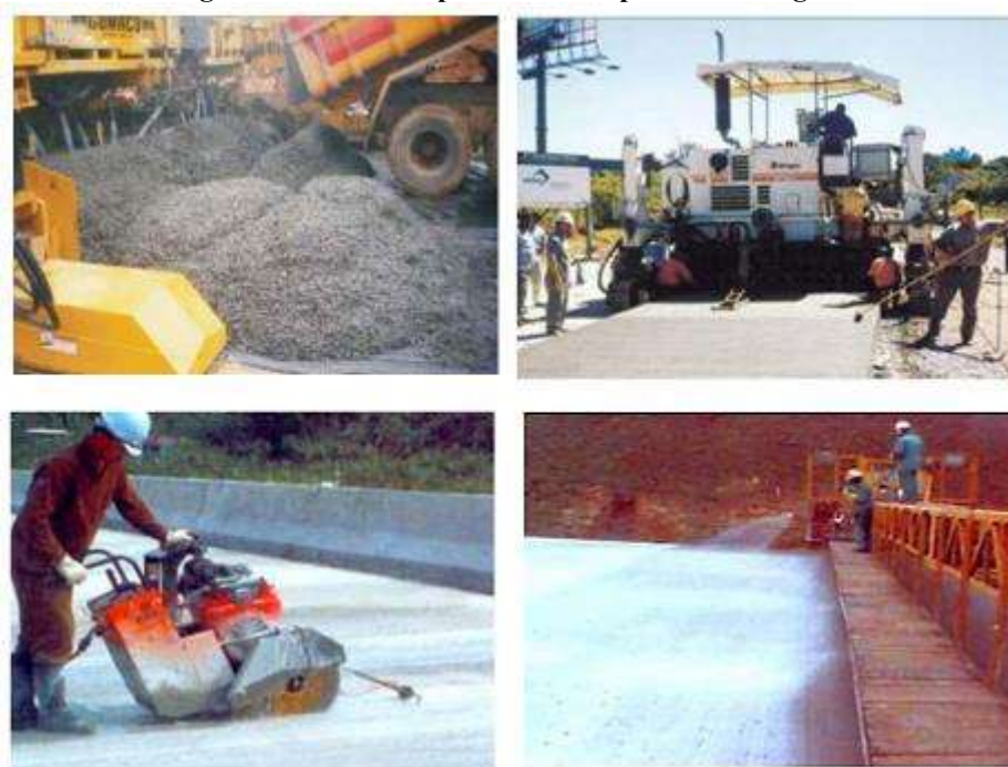
Figura 07 - Processo produtivo dos pavimentos rígidos.
