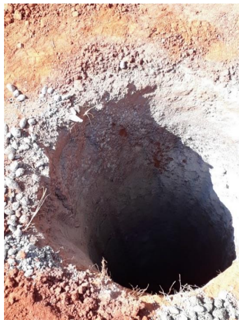
Figura 23 – Adição de cimento para controle da umidade nos furos
