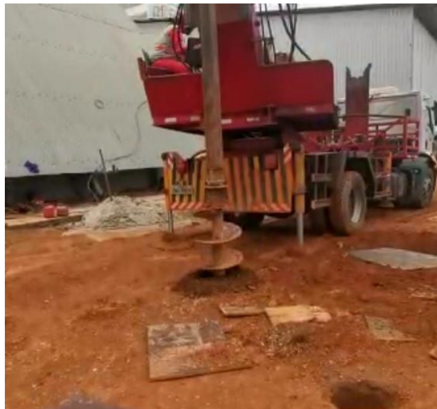
Figura 20 - Perfuração das estacas
