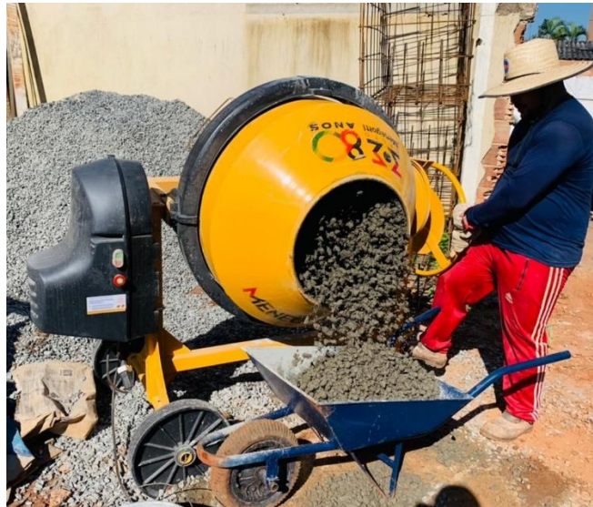
Figura 26 – Preparo do concreto
