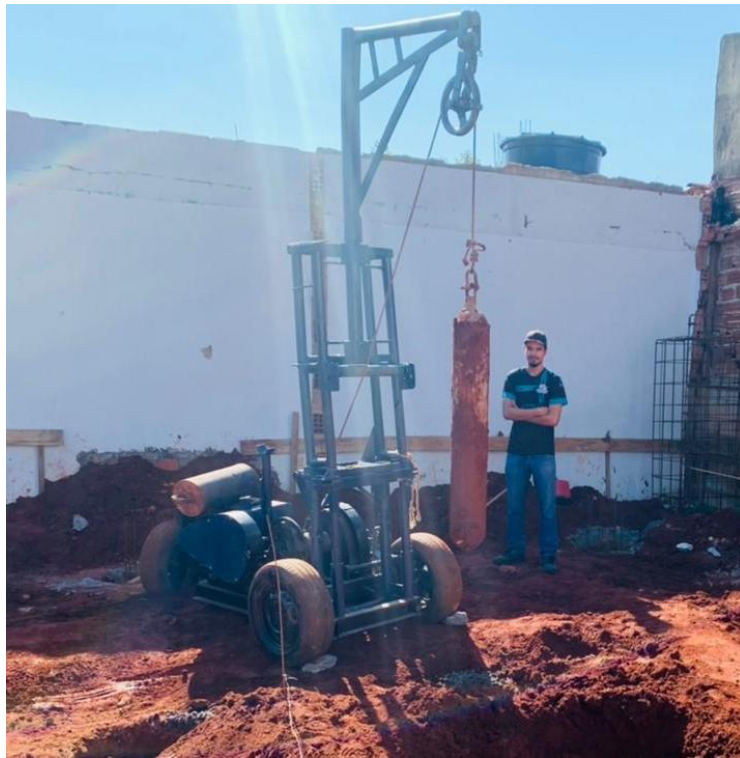
Figura 29 – Pilão para compactação
