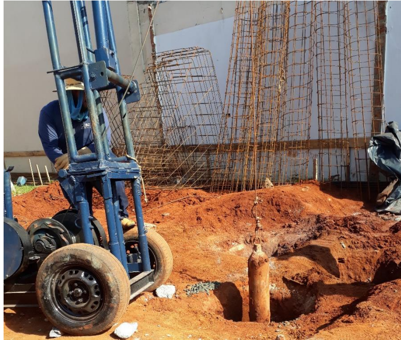
Figura 28 – Compactação do concreto
