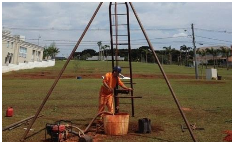
Figura 3– Ensaio de sondagem (SPT)
