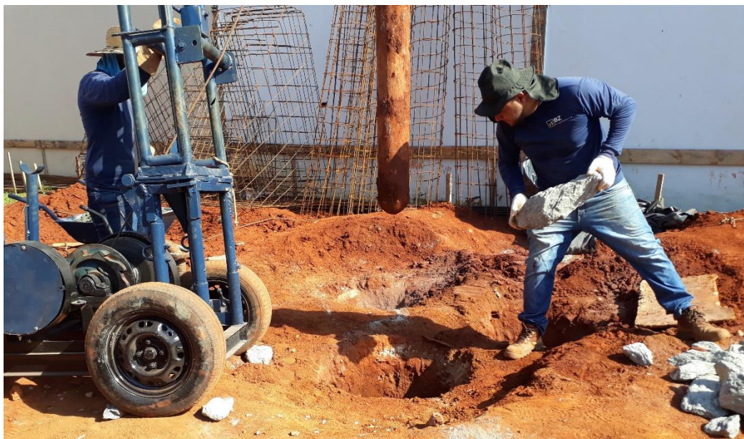
Figura 25 – Lançamento de pedras marroadas para apiloamento
