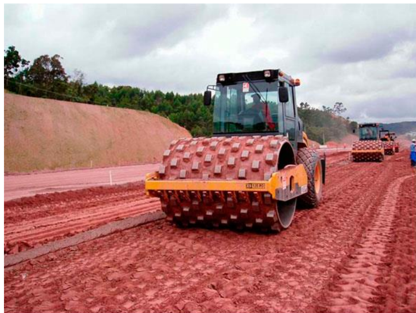
Figura 2 – Compactação do solo mecanicamente
