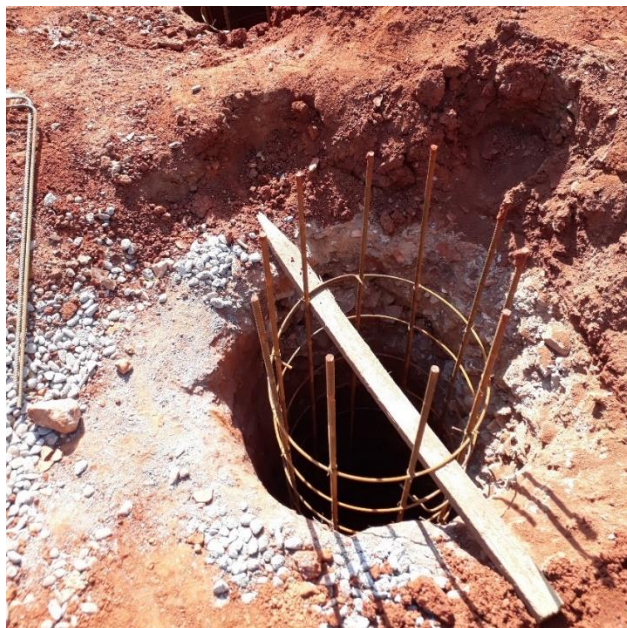
Figura 30 – Disposição da armadura
