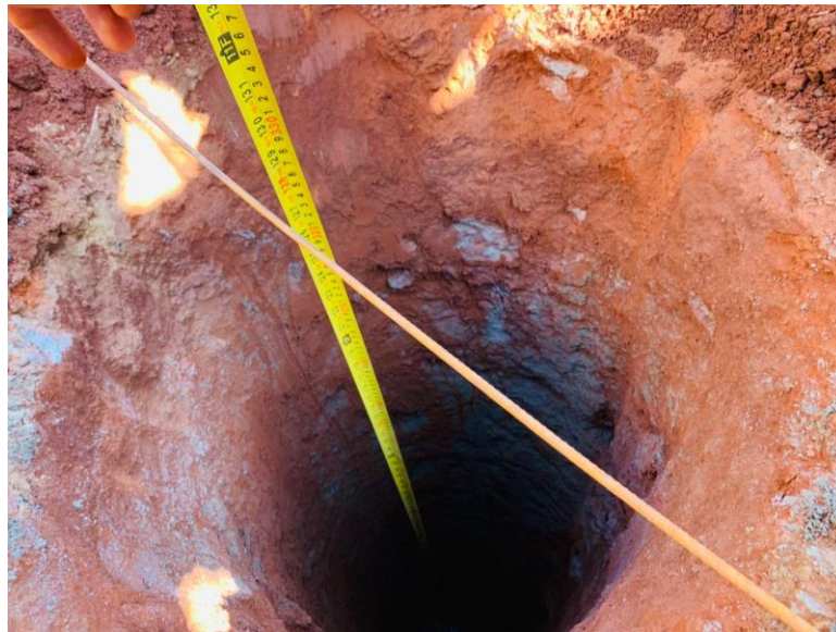
Figura 22 – Conferência da profundidade do furo
