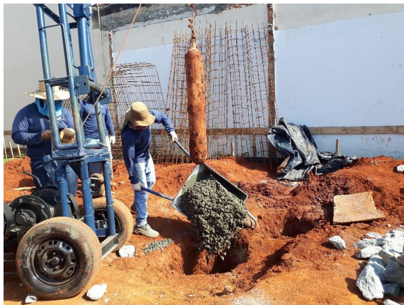
Figura 27 – Lançamento do concreto
