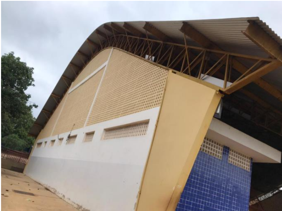
Figura 09 - Vista estrutura do telhado
