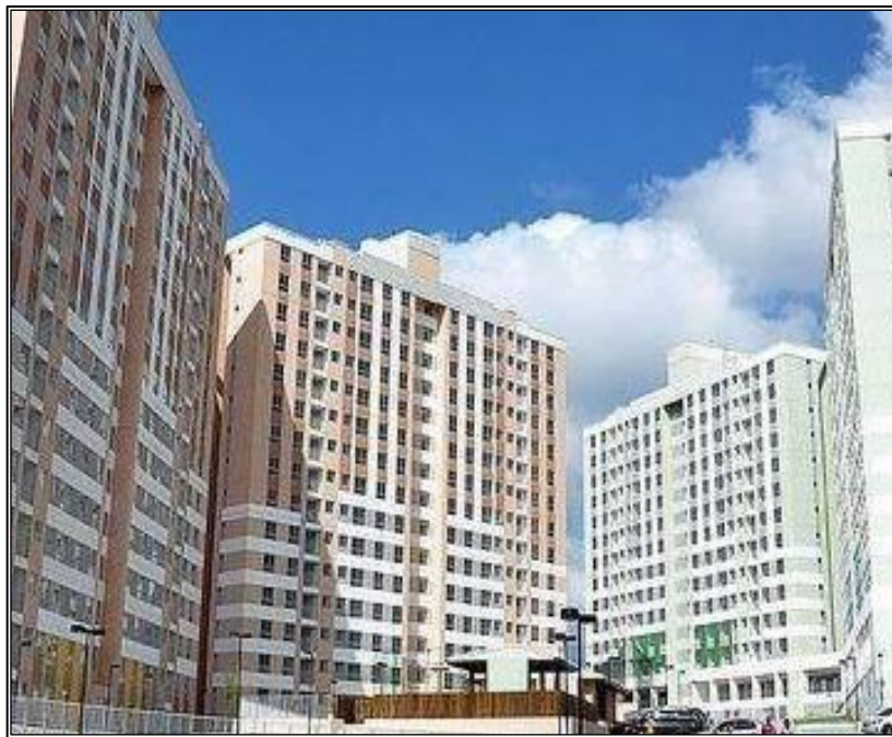
Figura 4 - Jardins dos Girassóis, primeiro empreendimento do Nordeste construído com Parede de Concreto com mais de cinco pavimentos. Salvador, BA
