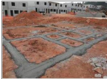
Figura 6 - Fundação – Viga Baldrame
