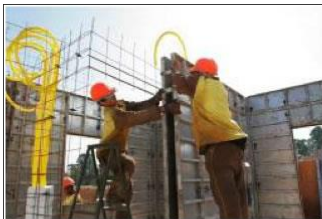
Figura 12 - Instalação e Montagem do Sistema de Fôrmas
