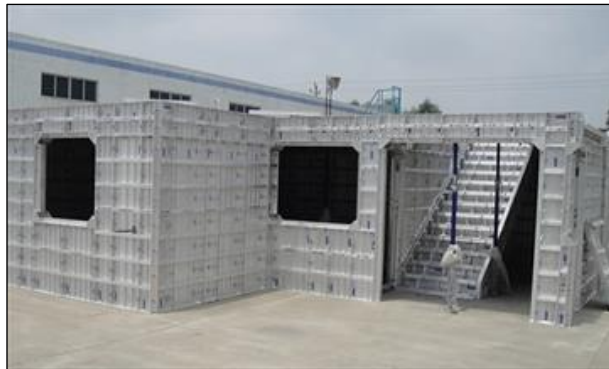
Figura 16 - Fôrmas de Alumínio Easysset
