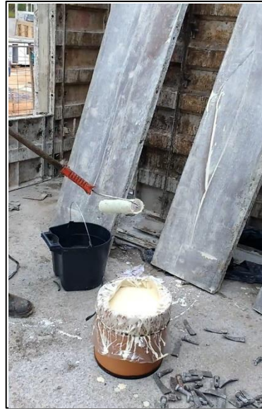
Figura 17 - Aplicação do Desmoldante nas placas
