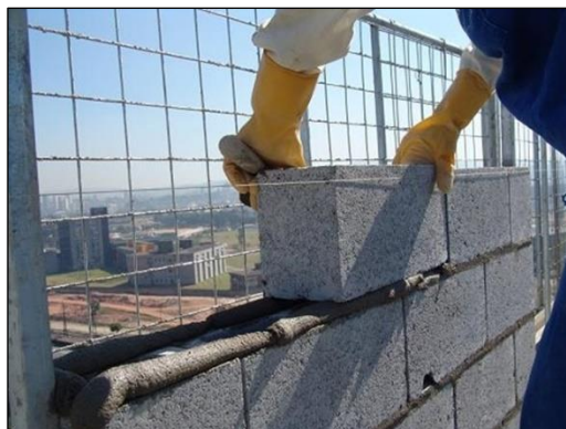
Figura 42 – Levantamento da Alvenaria
