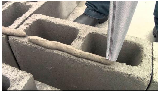
Figura 37 - Aplicação da Argamassa Polimérica com Bisnaga
