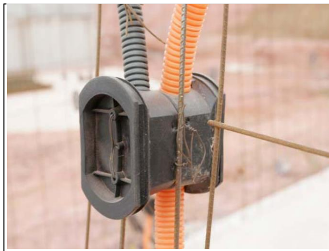
Figura 10 - Eletrodutos e caixas elétricas presos na armação
