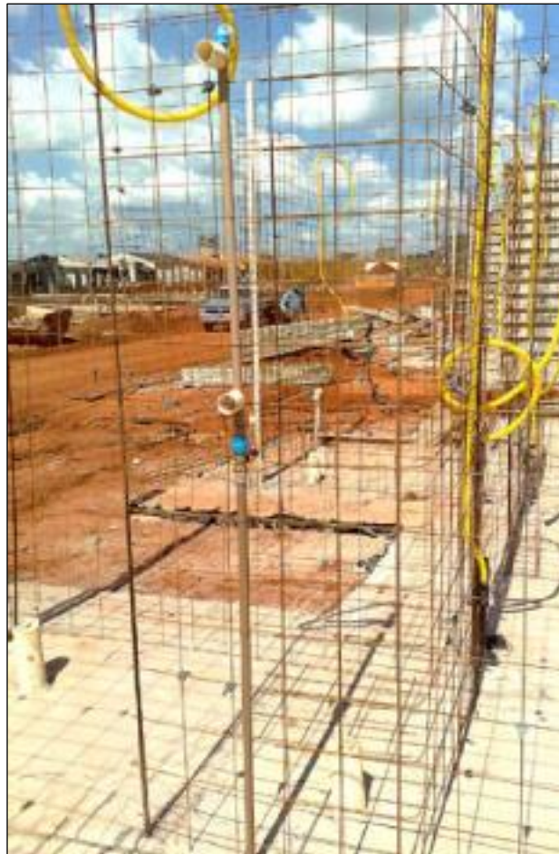
Figura 9 - Posicionamento das telas soldadas e fixação de eletrodutos
