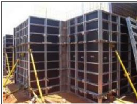
Figura 14 - Fôrmas Metálicas com Madeira Compensada
