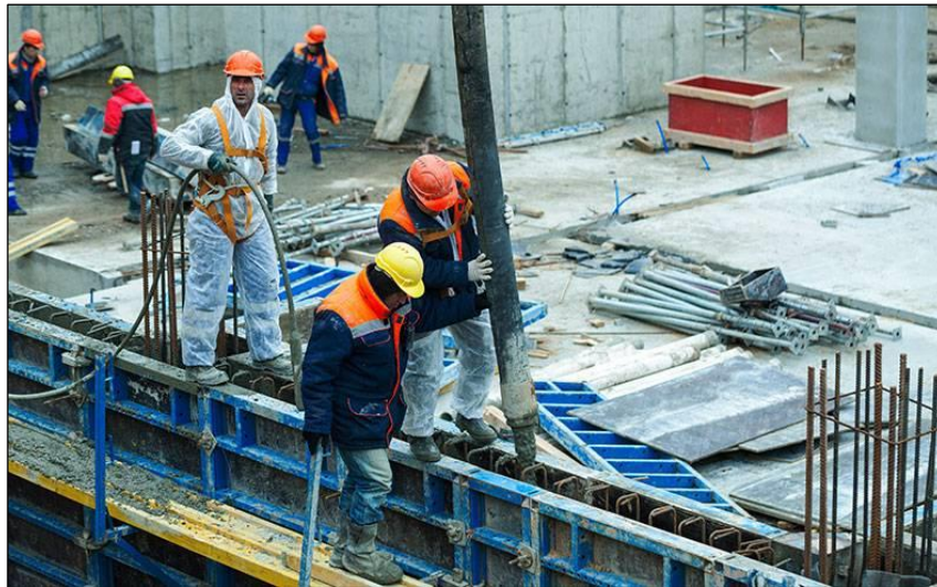
Figura 18 - Concretagem das Paredes
