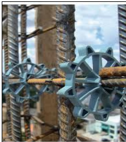
Figura 8 - Distanciadores para Espessura da Parede
