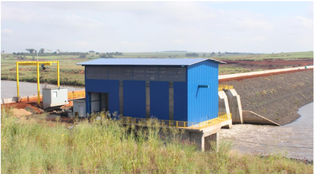
Figura 29-Casa de Força Coberta
