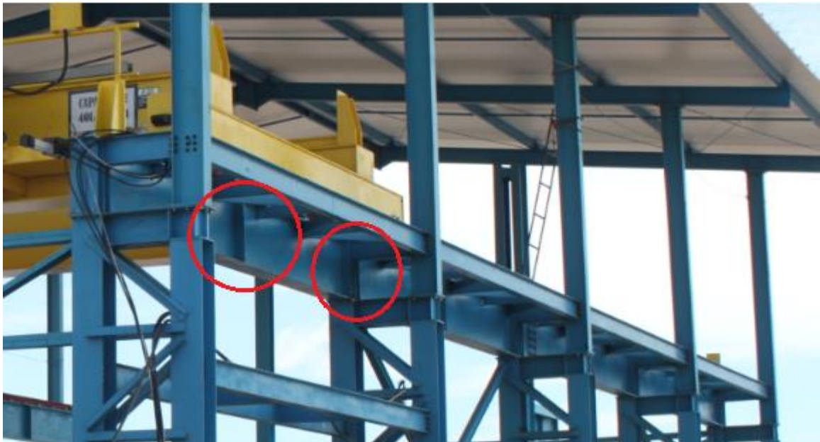
Figura 32- Enrijecedores na Viga de Rolamento
