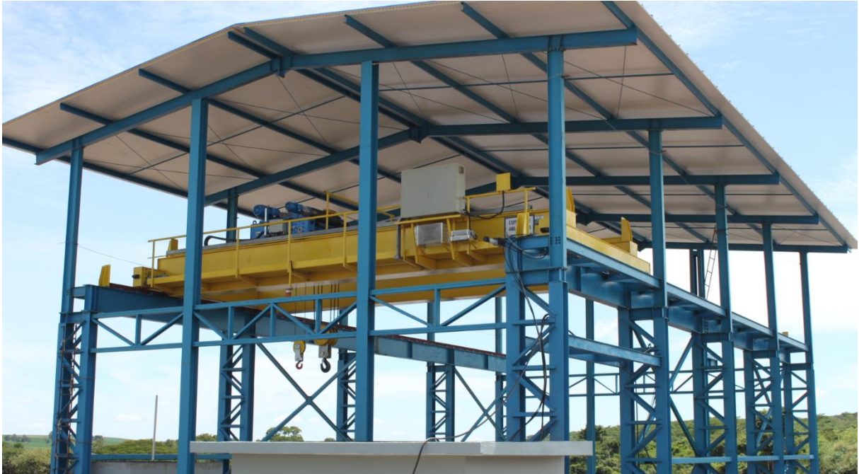
Figura 30-Esquema Estrutural que suporta a Ponte Rolante
