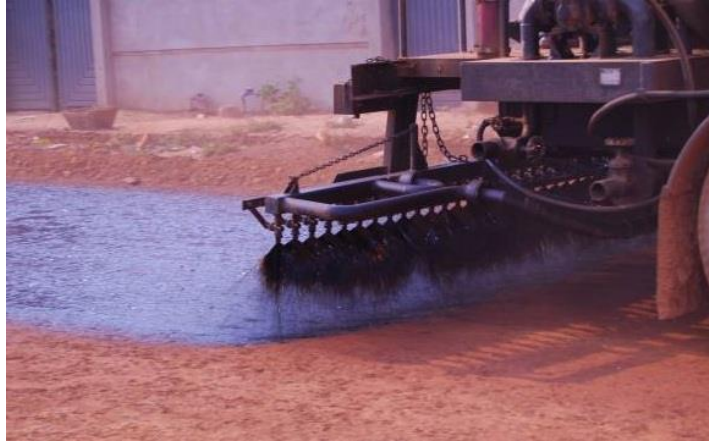
Figura 9: Aplicação da Pintura de ligação.
