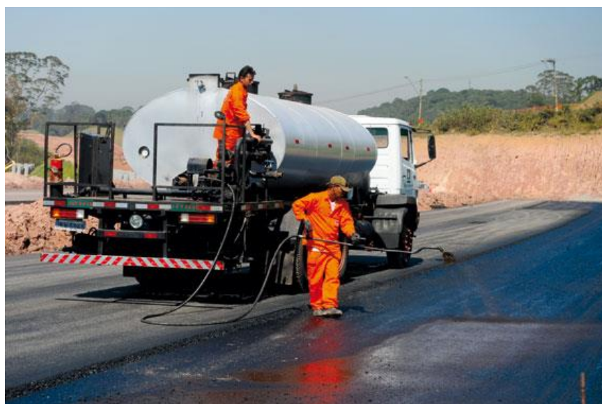
Figura 8: Aplicação do CM-30, imprimação.
