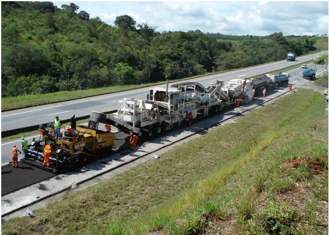
Figura 19: Execução de reciclagem a frio realizada pela Brow Brow na BR-116
