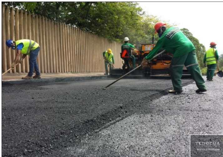
Figura 10: Distribuição do Asfalto CBUQ.
