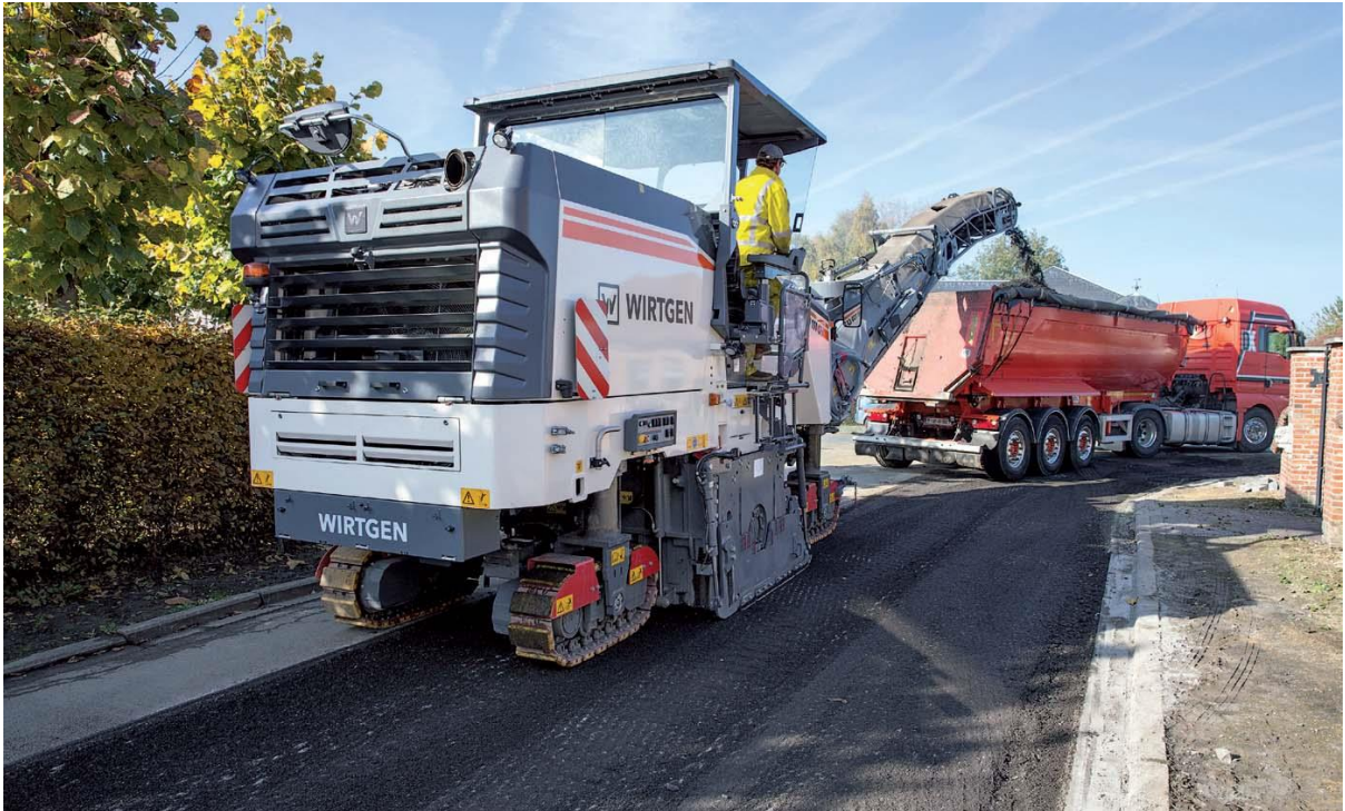
Figura 12: Fresagem de asfalto.
