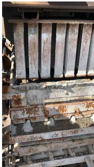
Figura 25 – Preenchimento da Fôrma com Concreto.
