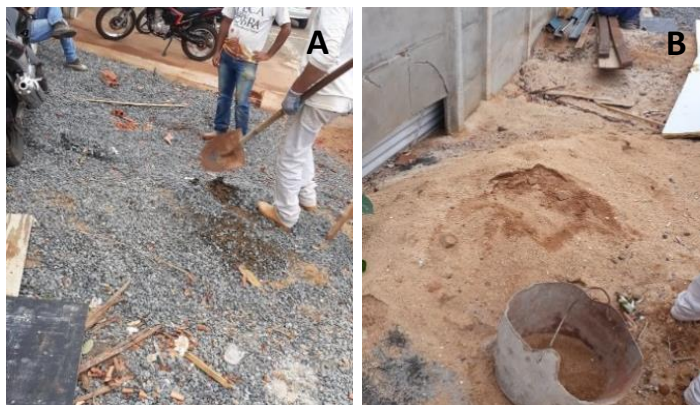
Figura 5 – Armazenamento do agregado graúdo (a) e miúdo (b) da obra 3.
