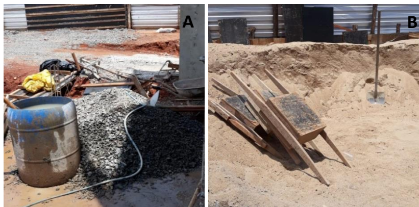
Figura 7 – Armazenamento do agregado graúdo (a) e miúdo (b) da obra 6.
