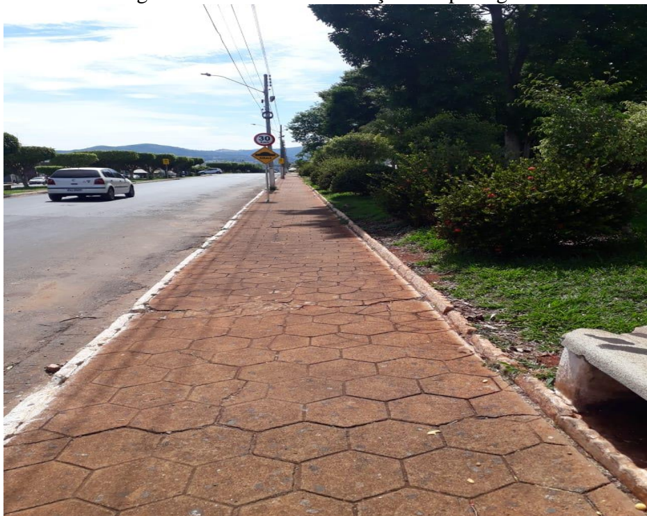
Figura 5 –Avenida Brasil calçada de passagem.
