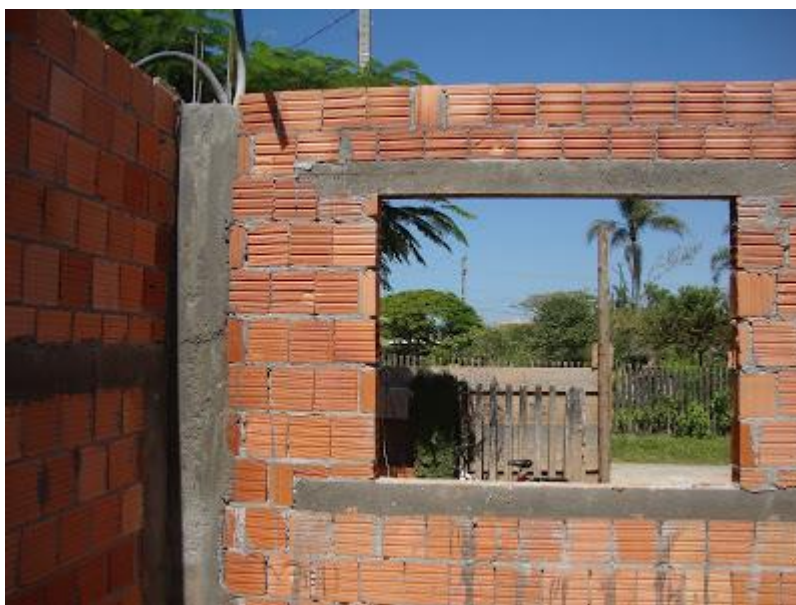
Figura 2.2. Assentamento de Bloco cerâmico de vedação.
