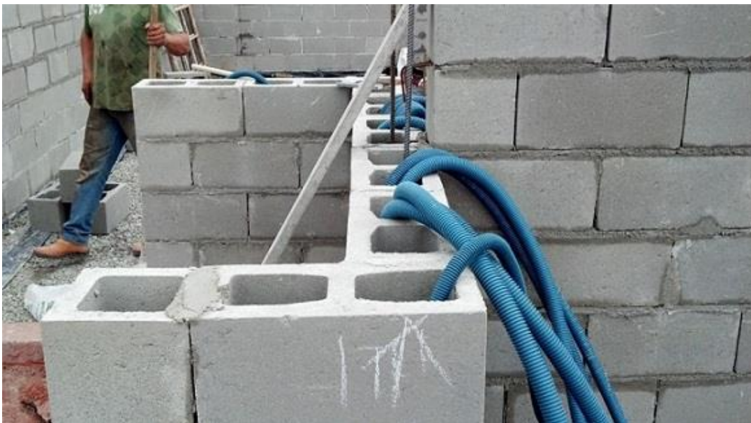
Figura 2.7. Execução de alvenaria em bloco de concreto vazado.
