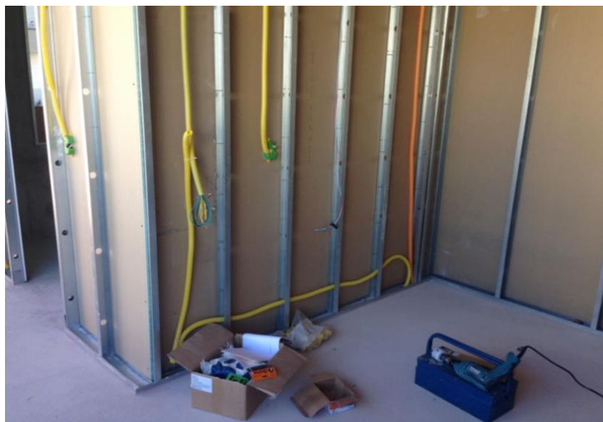
Figura 8- Execução das instalações juntamente com a placa de gesso.
