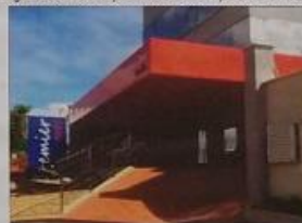
Figura 3: Acesso por meio de rampas na entrada
