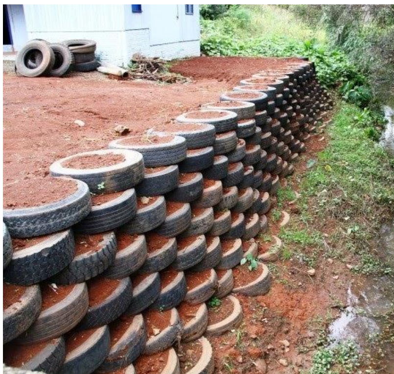
Figura 4 - Muros de arrimo com pneus nas margens do Rio Ponte Serrada
