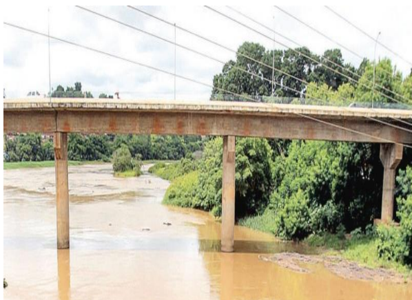
Figura 1- Ponte nova, construída no ano de 1982.
