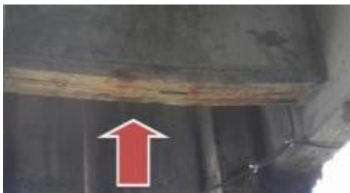
Figura 8. Viga com flexão
