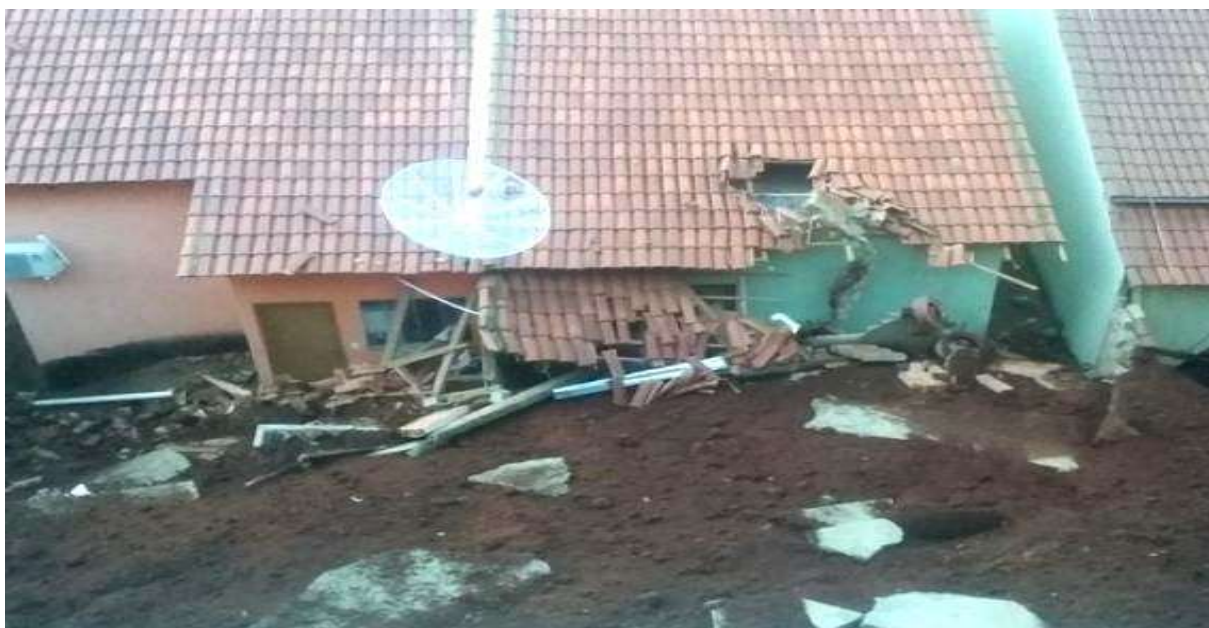
Figura 1 - Prefeitura apura deslizamento de terra que atingiu sete casas em Ceres.
