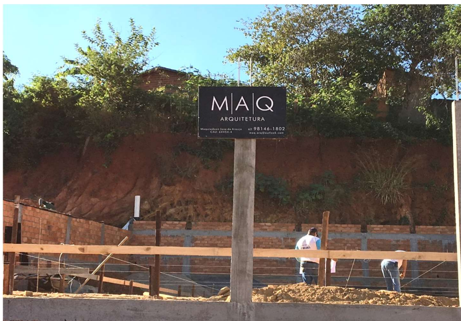
Figura 8 - Paredão de terra antes de ser cortado o talude
