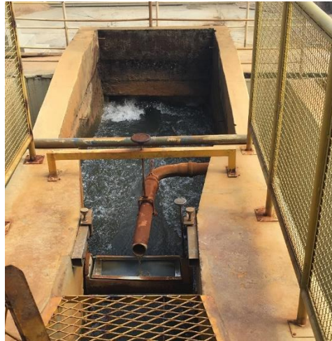
Figura 4 - Entrada nos tanques de mistura e decantação
