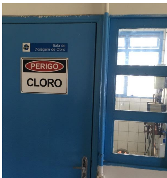
Figura 8 - Adição de cloro para controle biológico
