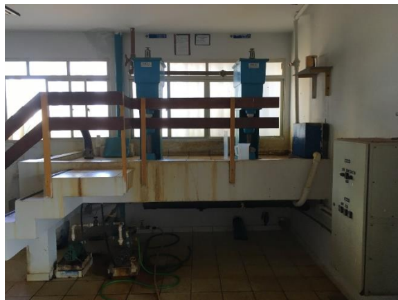
Figura 2 - Adição de sulfato de alumínio
