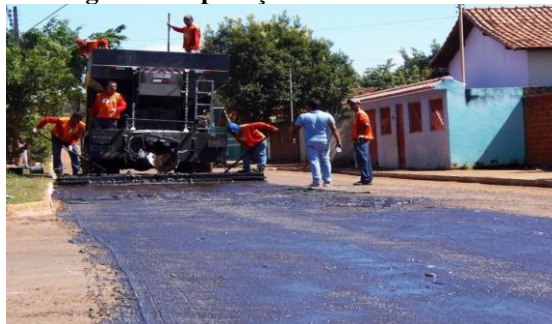
Figura 4 - Aplicação de Lama Asfáltica
